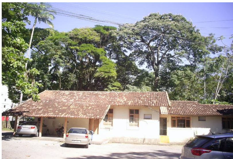
Fig.32- Parte da área com maior diversidade biológica ao fundo da edificação. Foto da autora em março de 2011.
