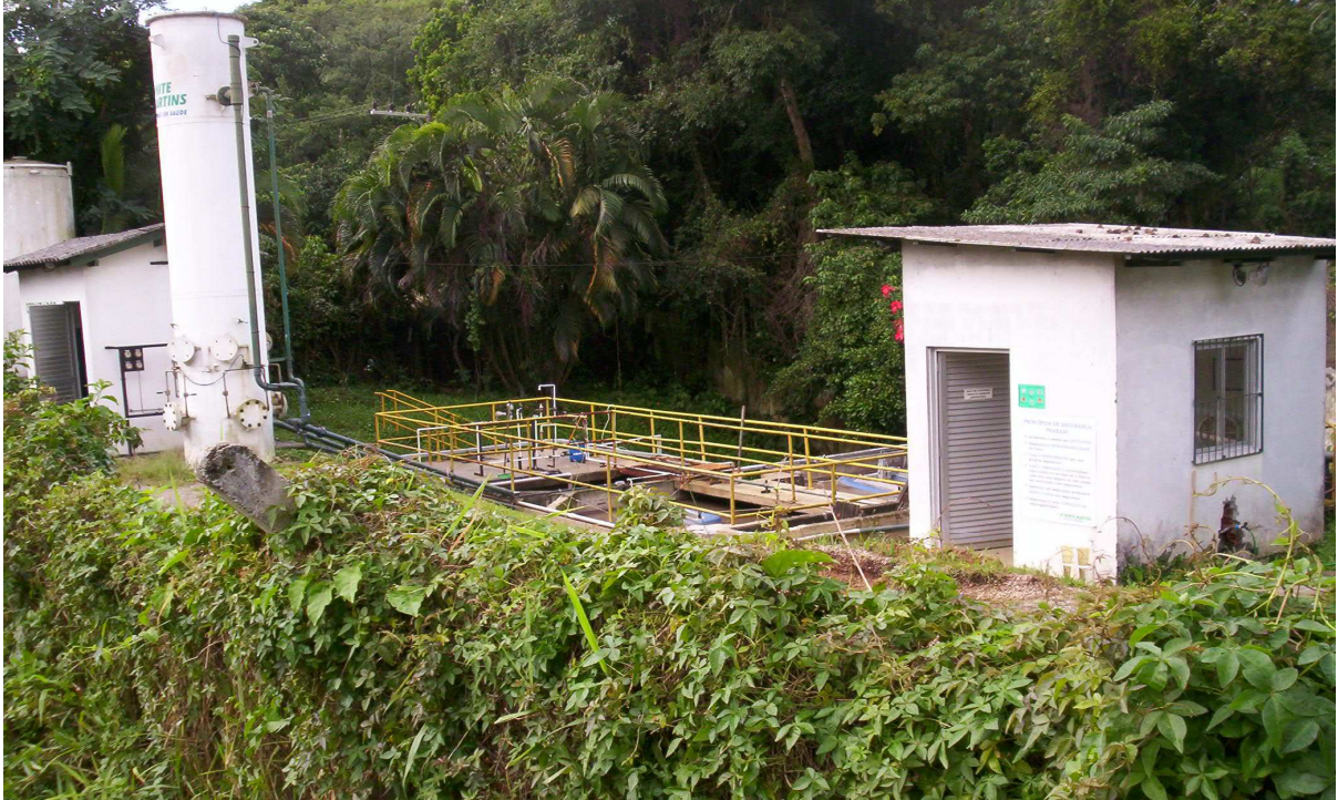
Figura 14: Tratamento dos efluentes dentro do pátio do hospital Y Fonte: dados da pesquisa (2010)
