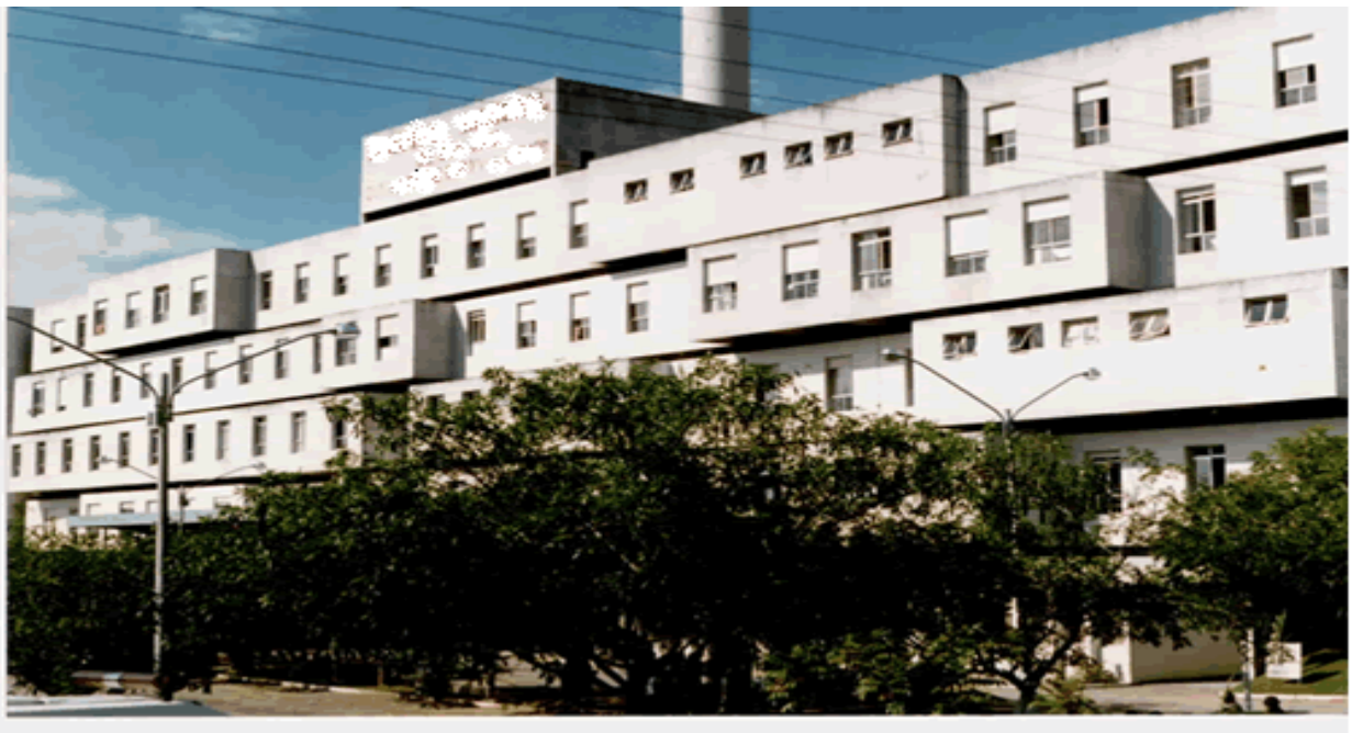
Figura 2: Vista frontal do hospital Y Fonte: Dados da pesquisa (2010)
