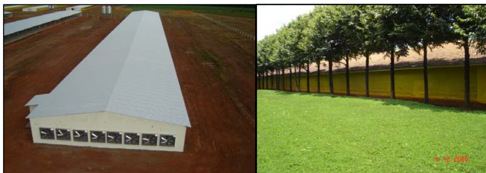
Figuras 13 e 14. Aviário com sistema de exaustores e quebra ventos. Fonte: Cobb.
