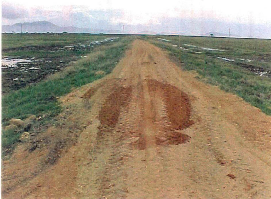
**Figura 24** – Ensaibramento dos taludes.
