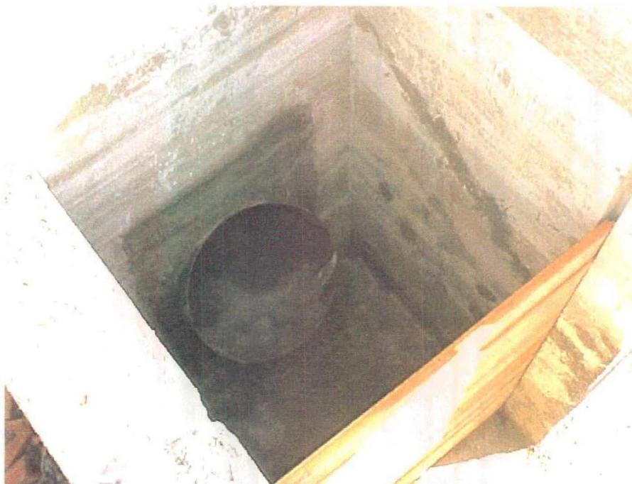
**Figura 22** – Tubulação da bomba chumbada na parede.
