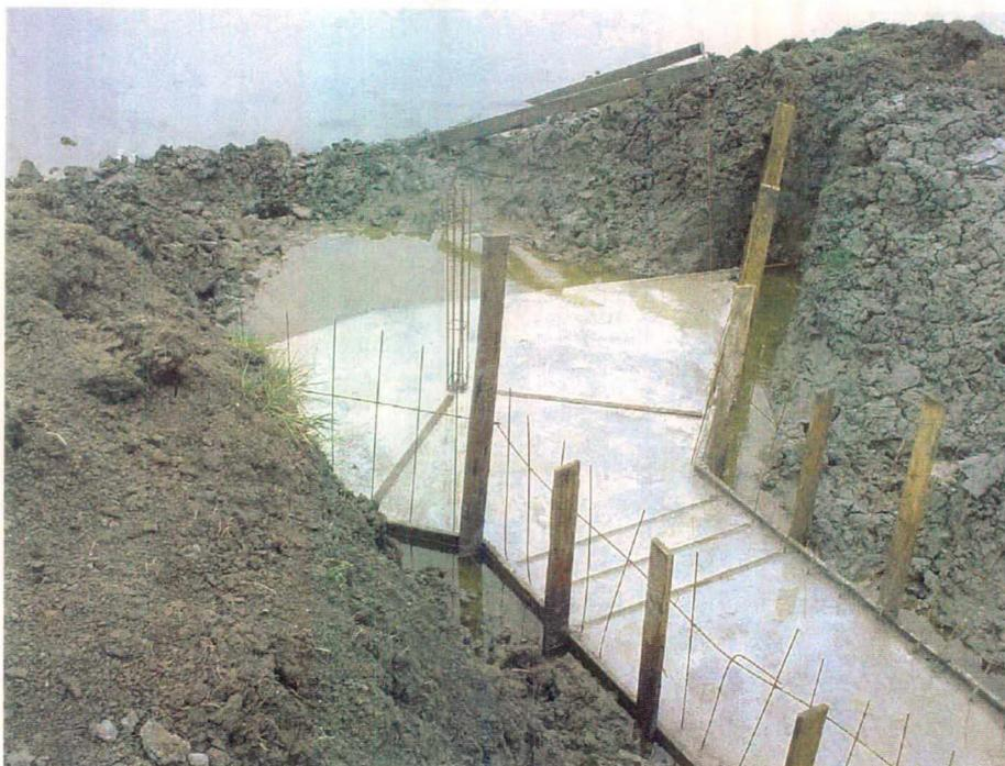
**Figura 14** – Concretagem da base da comporta.
