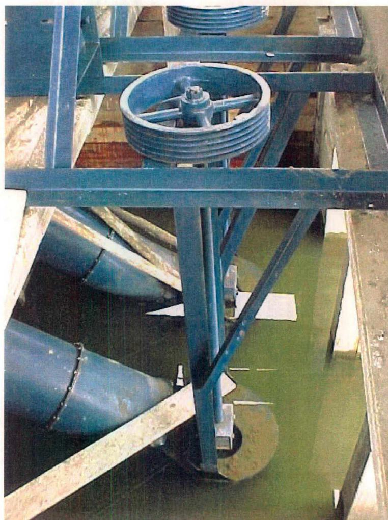
**Figura 21** – Bombas axiais com tubulação de 60 cm de diâmetro.
