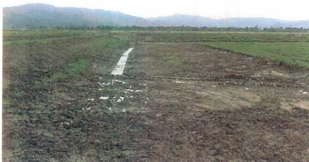
**Figura 10** – Construção de viveiro retirando-se aterro apenas de suas laterais.
