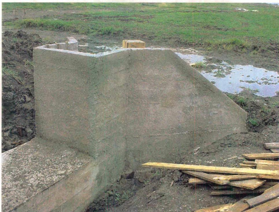
**Figura 19** – Detalhe da superfície áspera na parede externa da comporta, evitando infiltrações.
