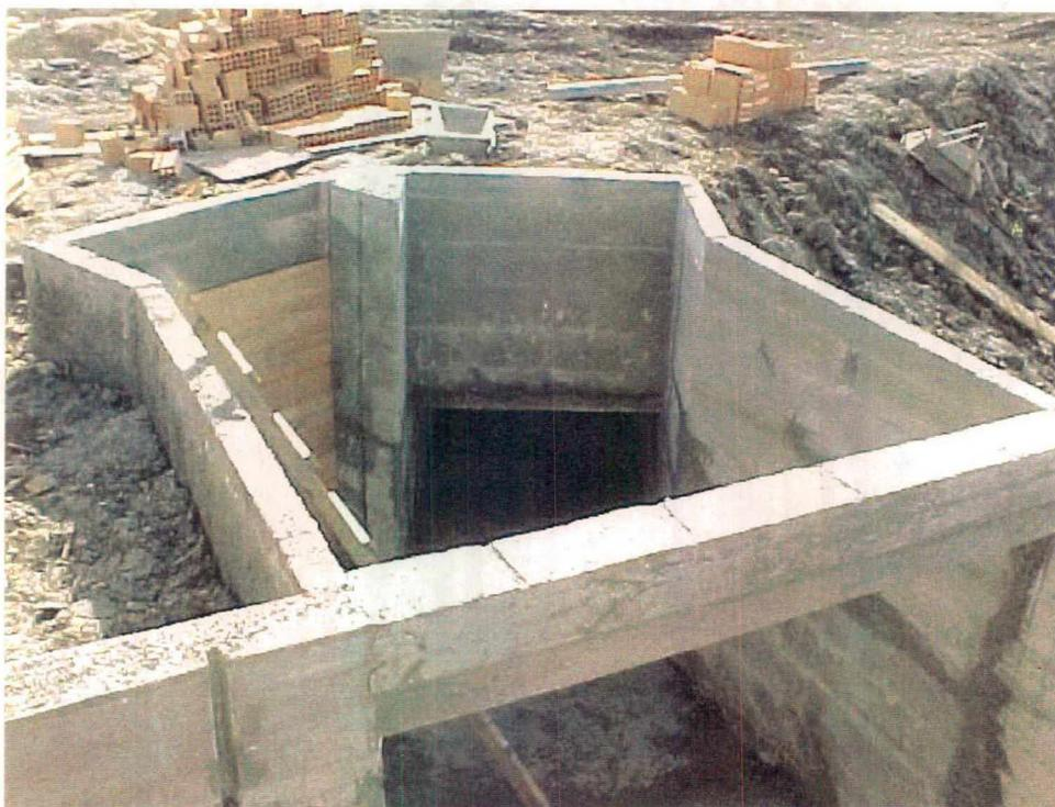
**Figura 23** – Galerias utilizadas para abastecimento dos reservatórios.
