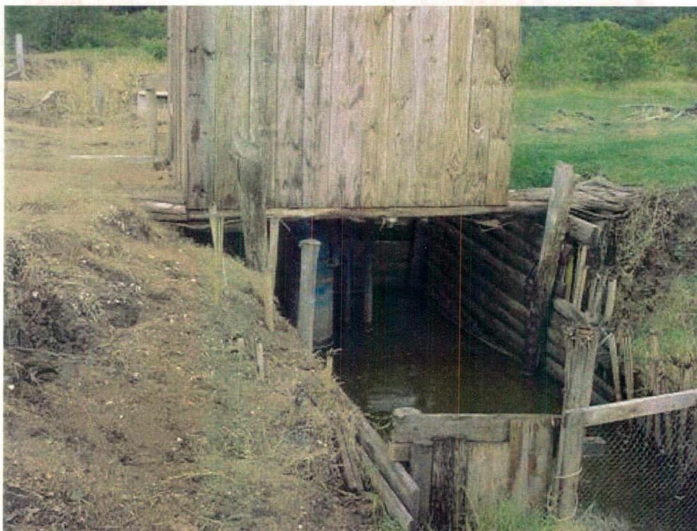
**Figura 2** – Estação de bombeamento para drenagem do terreno.
