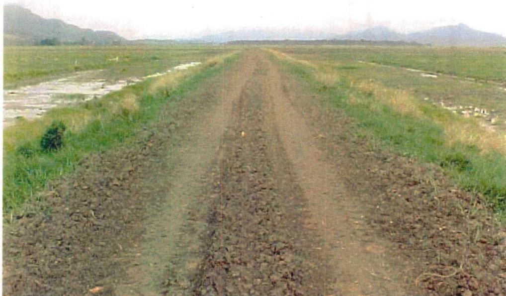
**Figura 4** – Crista de talude com 4 metros de largura.
