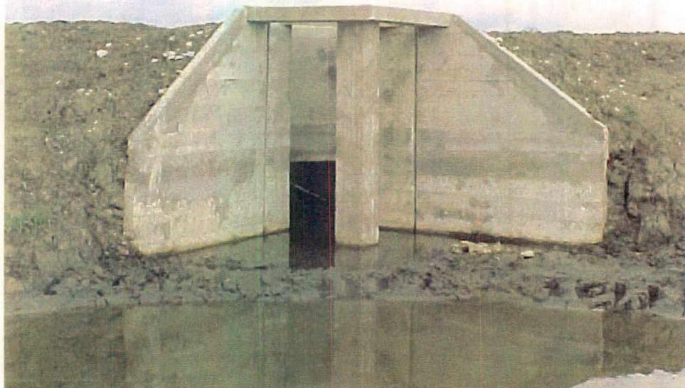
**Figura 13** – Comporta de drenagem construída em concreto armado.
