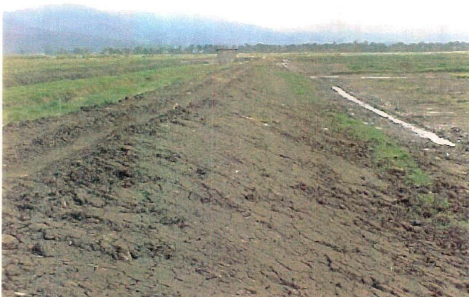
**Figura 3** – Talude interno recém construído com declividade 3:1.
