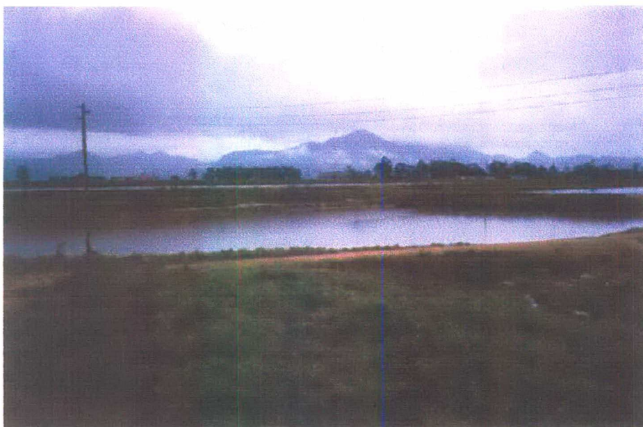
Figura 5. Tanque de Estabilização
