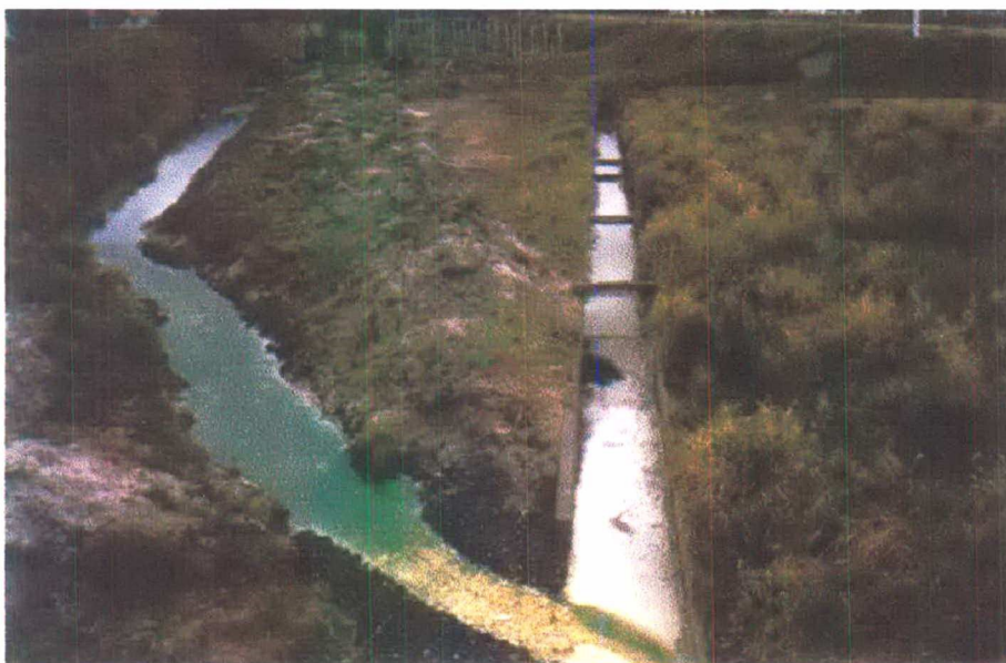
Figura 48. Valo e calha de drenagem com a presença de enxofre.
