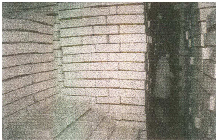
Fig. 40. Câmara de armazenamento.
