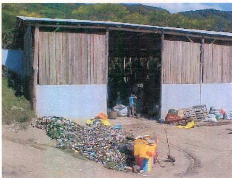
Figura 3. Galpão do centro de triagem Fonte: König Jr, 2003.
