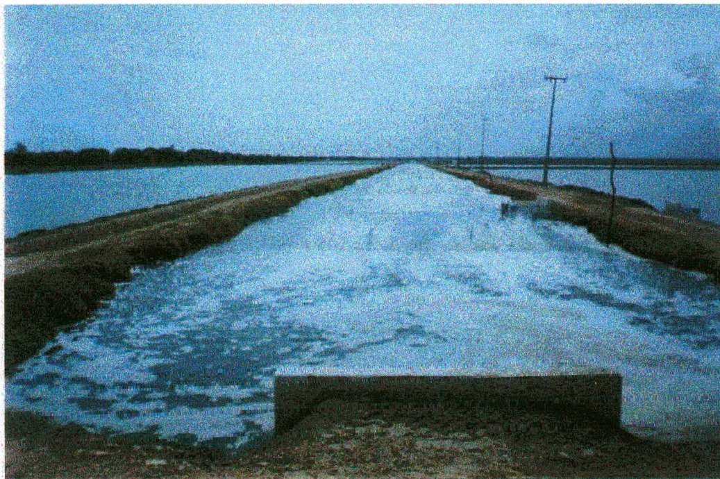
Figura 3 - Canal secundário de abastecimento.
