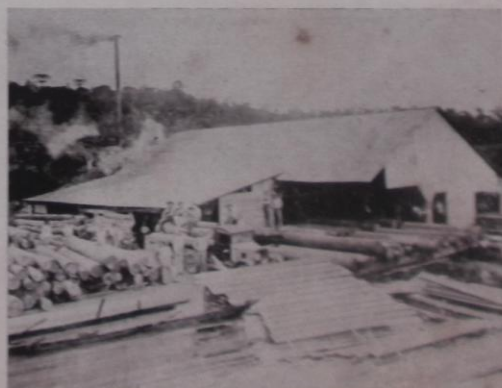
Galpão de uma serraria, vendo-se à esquerda o pilão para depósito de toras.
