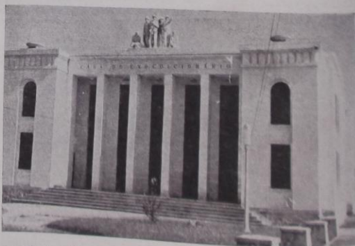
Casa do Expedicionário, construída pela associação constituída dos antigos praças e oficiais que estiveram na Europa defendendo a liberdade contra a tirania dos ditadores.
