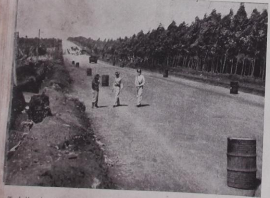
Trabalho de asfaltamento da rodovia Apucarana-Melo Peixoto. Note-se o reforçamento pelo plantio de eucalipto.
