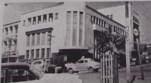
O sentido único já se faz necessário à regularidade do tráfego veicular nas ruas principais de Londrina. Aparece o edifício do Banco do Estado do Paraná.
