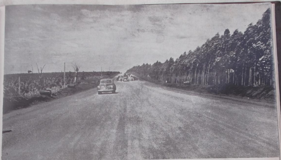
As boas estradas são complementos necessários a todos os empreendimentos de colonização. No trecho de ligação entre Arapongas e Aricaandava, que está sendo asfaltado, nota-se o reflorestamento marginal de eucaliptos, para consolidar o nível dos aterros.
