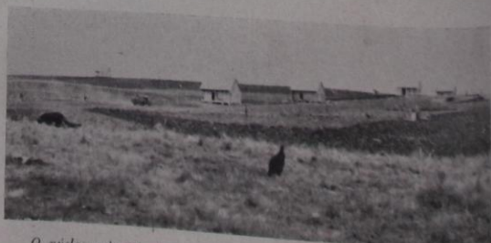
O núcleo colonial alemão de Entre Rios adota um sistema cooperativista de produção. Enquanto os arados cortam a terra, as casas de madeira vão sendo erguidas, dentro de alinhamentos planejados.
