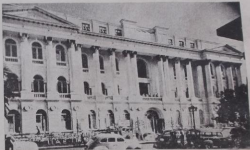
Curitiba — Universidade do Paraná. Vista da nova ala da Fac. de Engenharia.
