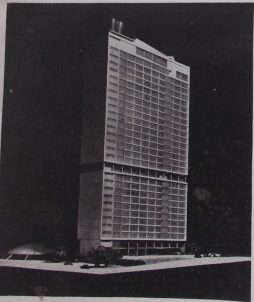
No Centro Cívico, o edifício de maior realce será o das Secretarias de Estado, cuja construção da estrutura aos poucos vai subindo até completar os 30 pavimentos projetados. Junto ao pavimento térreo a cúpula com 55 metros de diâmetro, sob a qual se alojarão a Recebedoria e a Pagadoria do Estado.
