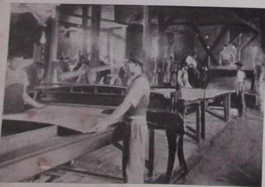
Fábrica de laminados. No primeiro plano: torno para laminação da madeira. No segundo plano: guilhotina para cortar as lâminas em tamanhos diversos.
