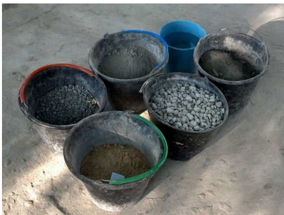
Figura 8 - Materiais pesados em baldes para preparo do concreto.
