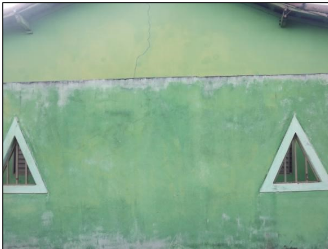
Figura 14 - Aspecto da calcinação
