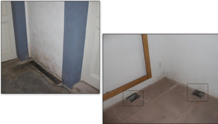
Figura 43 - Valas de aeração - Hall térreo do pavilhão central
