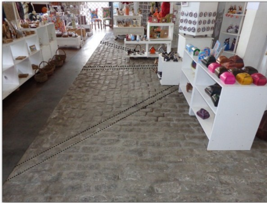
Figura 5 - Disposição das pedras em relação ao pilar: Casa da Alfândega
