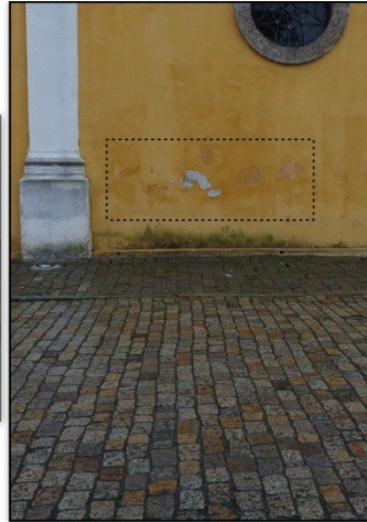
Figura 29 - Descascamento pontual da tinta a cal - Fachada sul
