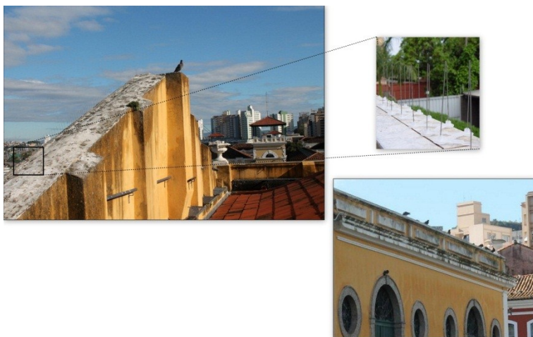
Figura 33 - Combate aos pombos - Ação das espículas
