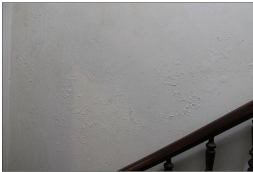
Figura 26 - Bolhas na pintura
