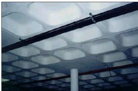
Figura 3 - Lajes sem elementos de enchimento
