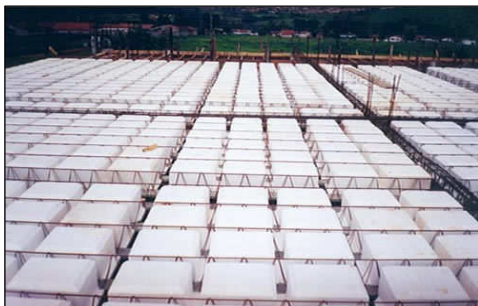
Figura 2 - Lajes com preenchimento de EPS
