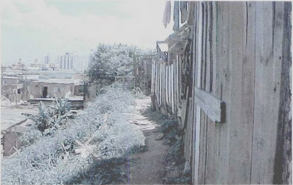
Foto 7 - Habitações em área de risco 16/12/2002
