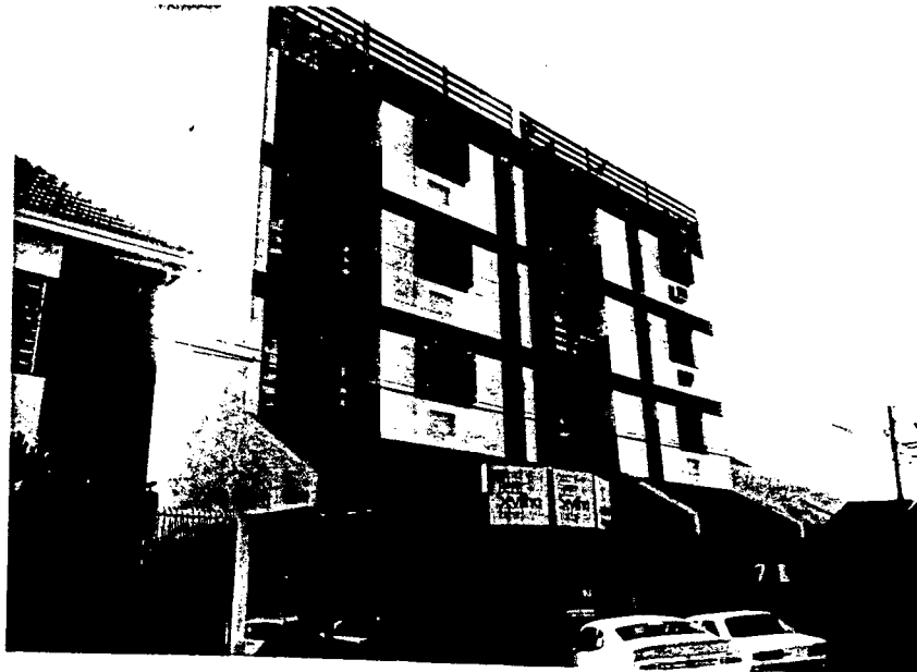
FIG. Nº 24: CONDOMÍNIO EDIFÍCIO SEVILHA (5 pavimentos) Rua José Bonifácio – Ijuí. Centro. (6/91) Incorp.: ARQUIENGE, Arquitetura e Engenharia Ltda.
