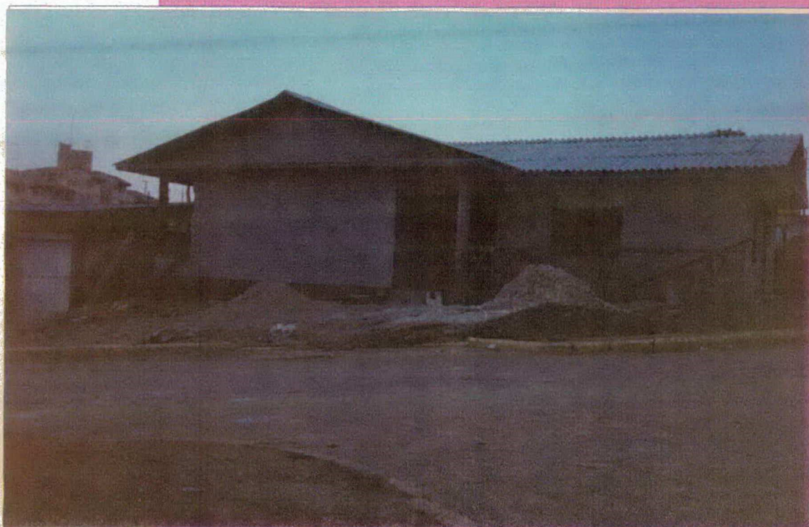
construção da creche 26 nov 94
