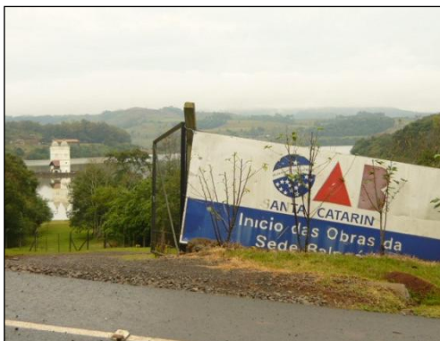
Figura 8 - Local da futura sede da OAB/SC nas margens do reservatório de Itá
