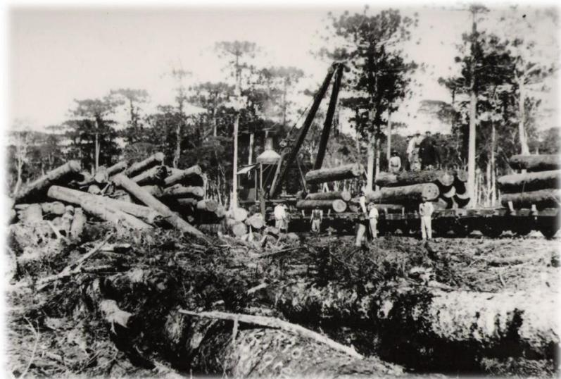
**Imagem 10: Embarque de vagões com toras na mata. O trabalho era efetuado com a ajuda de guinchos movidos a vapor comprimido, s/d. Imagem digitalizada. MTB.**
