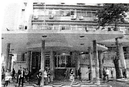
Região central. O Edifício das Diretorias, pilares e amplo espaço no térreo
