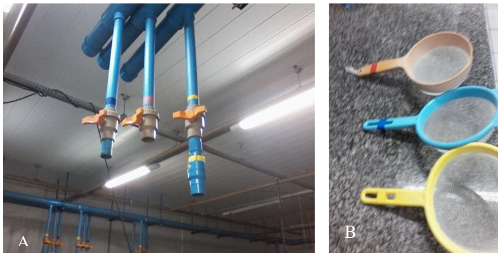
Figura 1. A) Saída de água dos sistemas de recirculação de água devidamente identificados com cores distintas (Fonte pessoal); B) Peneiras utilizadas em cada um dos sistemas de recirculação, devidamente identificadas com as cores semelhantes a de cada sistema (Fonte pessoal).
