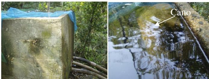
**Figura 26** – À esquerda, vista parcial do filtro de areia e brita coberto com tela. Na foto à direita detalhe interno da caixa, onde vê-se o cano que conduz a água para o reservatório com tela protegendo-o, evitando assim a entrada de folhas e de outros materiais. Foto: Marcia Cesa.
