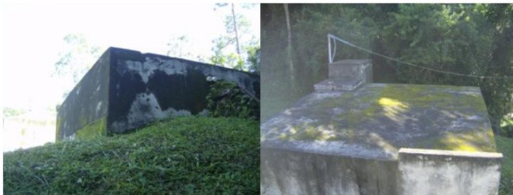
**Figura 39** – Duas visadas do reservatório com capacidade para 10.000 litros. Depois de passar pelos filtros, a água vai para a caixa para receber o hipoclorito de sódio. Foto: Marcia Cesa.
