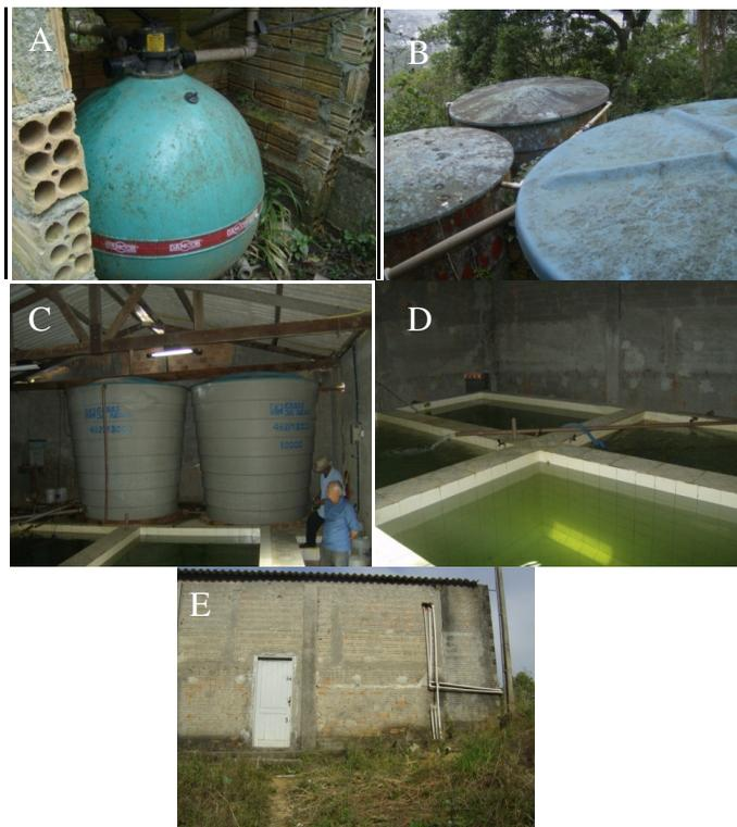
**Figura 24** – Vista parcial dos equipamentos usados pela SAC ACOLJOGOC. Na foto vê-se o filtro DANCOR utilizado antes das caixas d'água (B); Nas fotos C e D vista parcial da parte interna do reservatório onde se vê as caixas d'água de 10.000 litros e os tanques onde é adicionado o cloro. Na foto E, vista externa do reservatório. Foto: Marcia Cesa.
