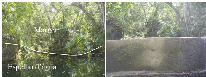
**Figura 25** - Vista parcial da área de captação da SAC Sol Nascente, onde foi construído um pequeno barramento com cerca de 80 cm de altura e 4 metros de largura. Foto: Marcia Cesa.
