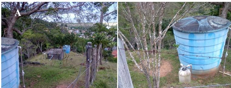
**Figura 15** - Na foto 15A podem ser vistas as duas caixas d'água e o reservatório de água de concreto entre ambas com os respectivos filtros Europa F5000. Na foto 15B tem-se uma visão do filtro situado ao lado de cada uma das caixas d'água.
