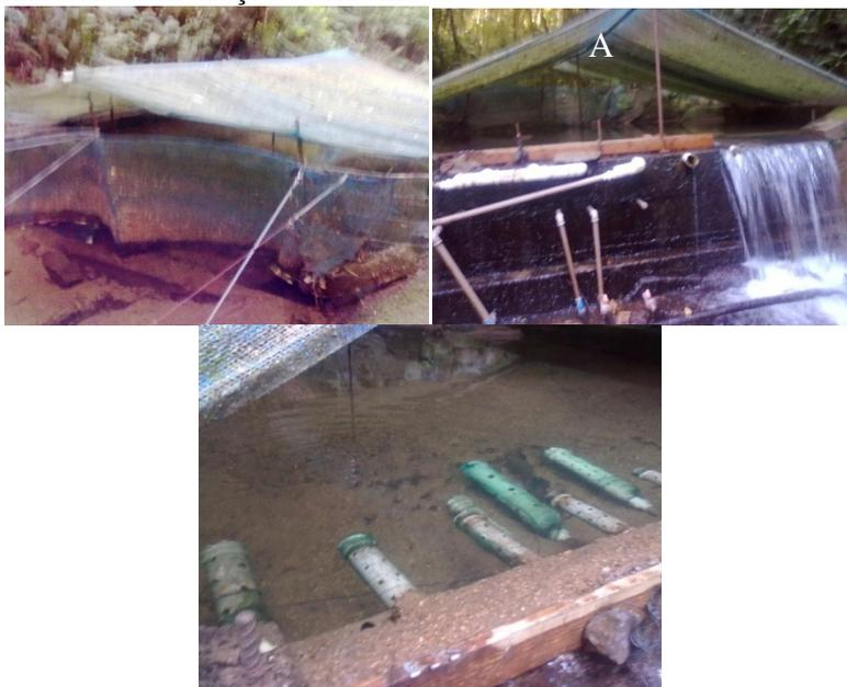
**Figura 30** – Vista externa da área de captação da AUAMBA (A e B) e vista interna, na qual podem ser observados os sete filtros feitos de terminais de canos de PVC com tela (C). A área é coberta para evitar a entrada de galhos e folhas e é cercada para evitar a entrada de gado, criado no entorno. No entanto, este gado tem acesso ao rio a montante desta captação. Foto: Marcia Cesa.
