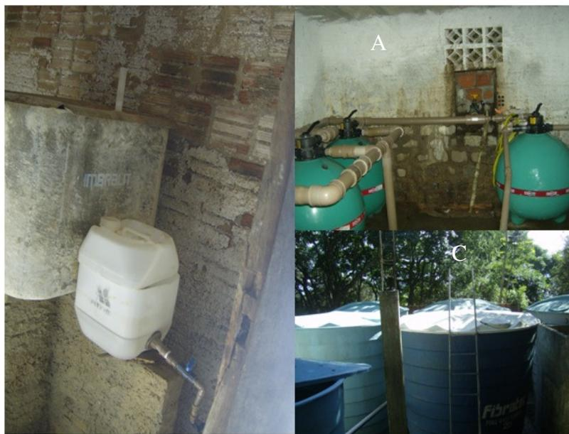
**Figura 29** – Vista parcial do processo de tratamento utilizado pela APROCRUZ. Na Figura 29A observa-se o equipamento de diluição do hipoclorito depois de passar pelos filtros (29B) e na 29C as caixas d'água utilizadas como reservatórios. Foto: Marcia Cesa.
