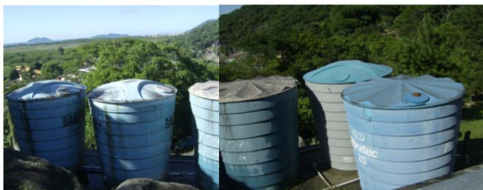
**Figura 40** - Vista parcial dos reservatórios de água, constituídos por 5 caixas de água de 20.000 litros cada. Foto: Marcia Cesa.
