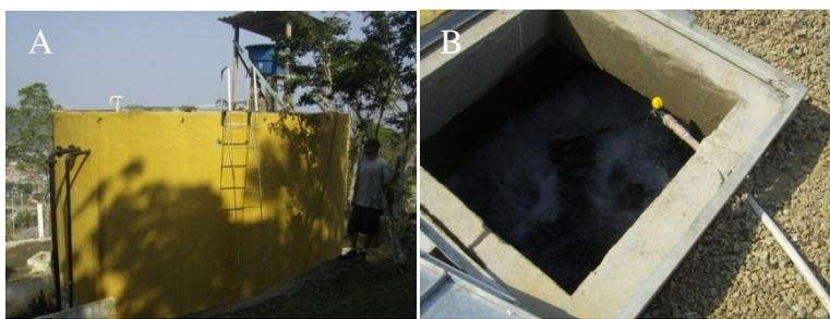
**Figura 27** - Vista parcial do reservatório. Observa-se na Figura 27A na parte superior do reservatório a caixa de 500 litros para diluição do cloro e na Figura 27B a aplicação de cloro na parte superior do reservatório, por meio da torneira que está conectada com a caixa de diluição. A abertura na parte superior do reservatório está constantemente tamponada. Foto: Marcia Cesa.
