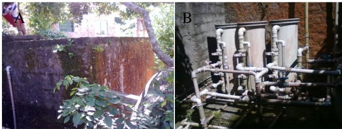
**Figura 31** – Vista parcial do reservatório (A) e dos filtros na saída da água para a distribuição (B). Os filtros possuem cerca de 1,20 m de altura. Foto: Marcia Cesa.
