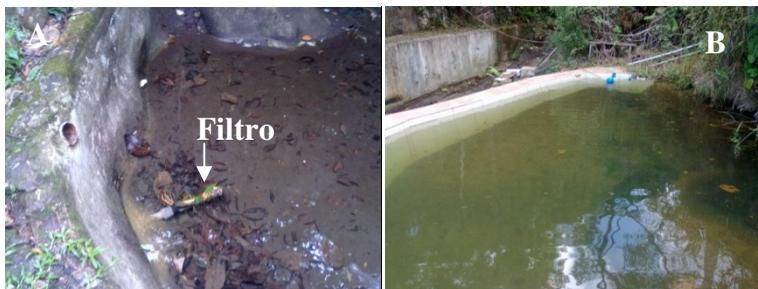
**Figura 14** – À esquerda observa-se a barragem na área de captação da Kumakola que encontrava-se com pouca água devido à estiagem. À direita observa-se o reservatório azulejado que apresentava-se com muita carga sólida dentro do mesmo constituída por sedimentos argilosos e matéria orgânica. As paredes do reservatório apresentavam incrustações de sedimentos, evidenciando que o mesmo não era limpo há muito tempo. Foto: Marcia Cesa, mar/2012.
