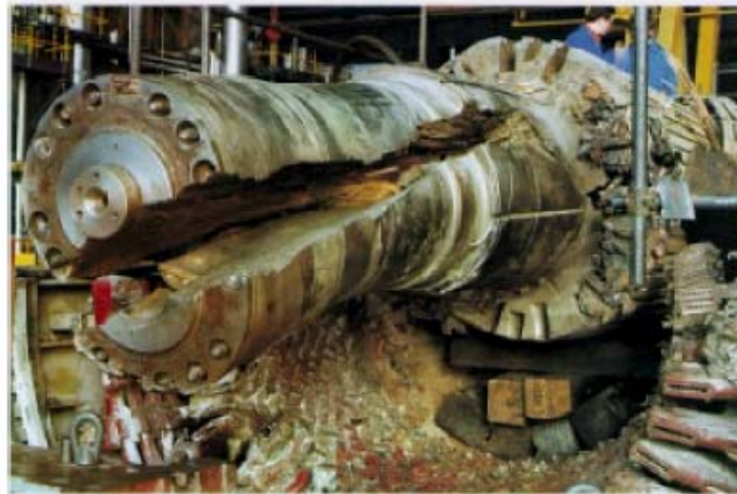
Figura 1– Efeito torcional em um eixo de gerador devido à presença de correntes harmônicas [3].
