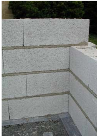
Figura 189: Alvenaria de blocos confeccionada com o cimento BIA- formulação B6.
