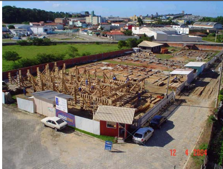
Figura 31: Vista panorâmica do local de implantação de um empreendimento da empresa.
