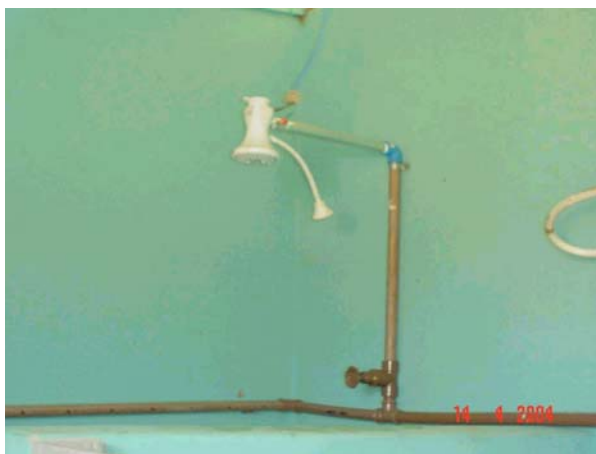
Figura 42: Chuveiro da obra.
