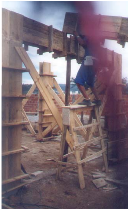
Figura 44: Andaime utilizado na obra.
