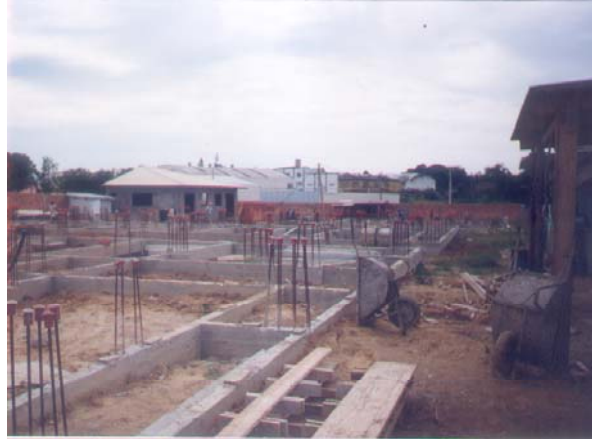
Figura 39: Visão geral da organização do canteiro de obras.
