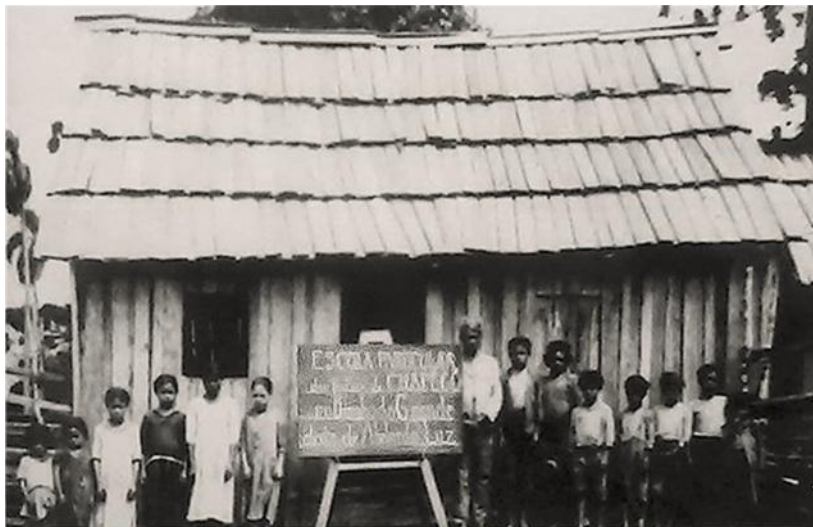
Figura 5 - Escola Particular dos Índios de Chapecó (Aldeia Banhado Grande – TI Xaçecó/1937)
