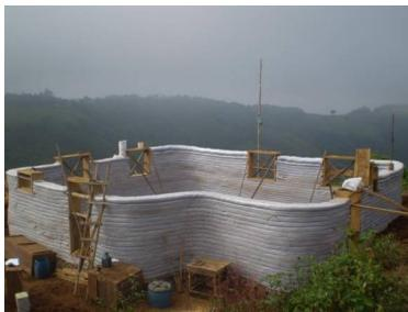
Figura 59: Paredes de taipa ensacada.
