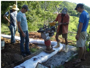
Figura 53: Início da construção das paredes.
