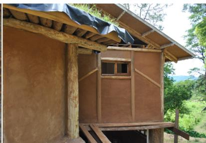
Figura 90: Face externa das paredes, já com o reboco.
