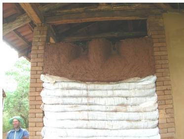
Figura 23: Parede de *cob* construída sobre parede de taipa ensacada.
