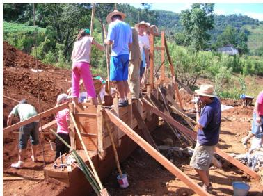
Figura 20: Construção de parede de taipa de pilão durante curso de bioconstrução
