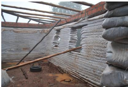
Figura 72: Parede norte da residência da família Borges, antes do reforço estrutural feito entre as janelas.
