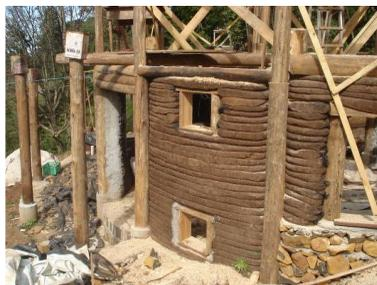
Figura 38: Paredes de taipa e estrutura de madeira.
