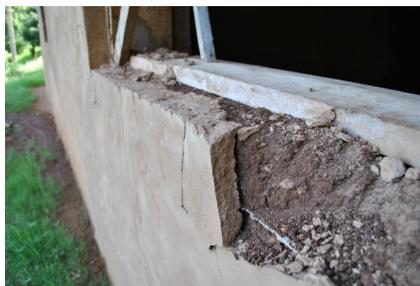
Figura 81: Família Borges: reboco grosso para corrigir imperfeições das paredes. Entretanto, não houve coesão.
