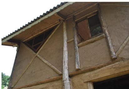
Figura 39: Vista parede de taipa de mão, fachada sul.
