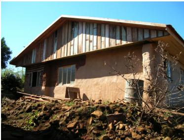
Figura 79: Família Bueno: paredes regulares e esquadrias reforçadas
