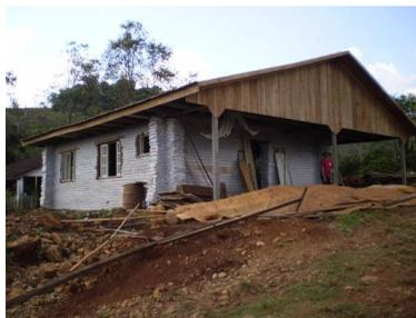
Figura 33: Vista paredes de taipa ensacada: família Bueno.
