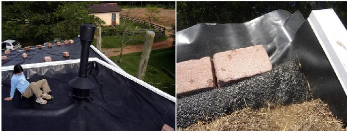
Figura 7: Exemplo de telhado vivo impermeabilizado com geomembrana. À direita, detalhe da drenagem com brita. Acervo da autora.
