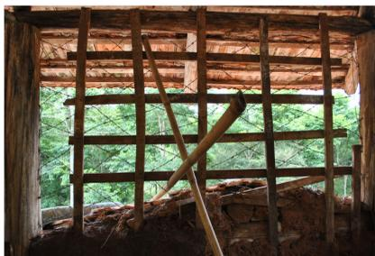
Figura 87: Trama com madeira e tela metálica na casa da família Montes.
