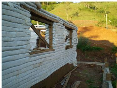
Figura 21: Parede de taipa ensacada construída sobre a parede de taipa de pilão.
