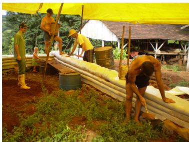
Figura 77: Família Bueno: início da execução das paredes e o cuidado da compactação nas laterais.
