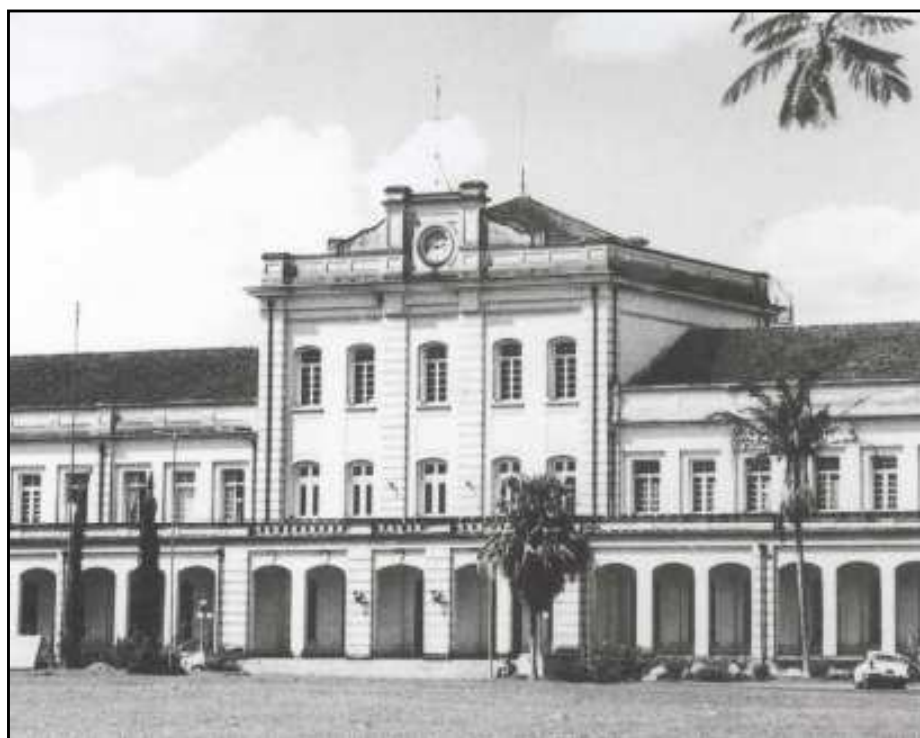
Figura 20: Fachada da ESALQ – USP. Sem data.
