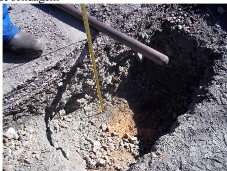
Figura 42 – Janela de sondagem
