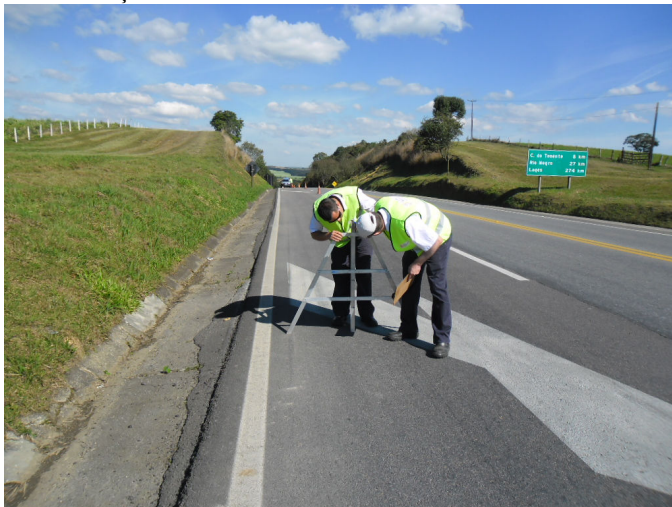
Figura 52 – Verificação das flechas km 183+620
