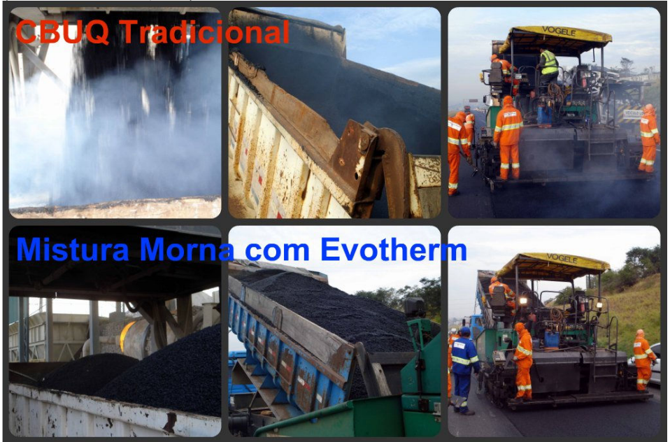
Figura 10 – Comparação entre misturas asfálticas com Evotherm e tradicional (MEADWESTVACO, 2011)
