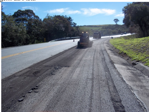
Figura 41 – Execução de fresagem na pista
