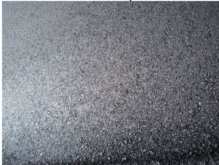
Figura 47 – Aspecto visual final da camada compactada
