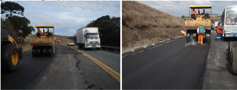
Figura 46 – Compactação do CBUQ
