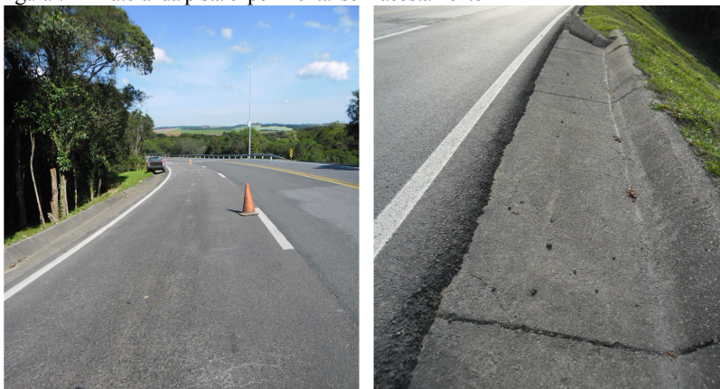
Figura 74 – Lateral da pista experimental sem acostamento
