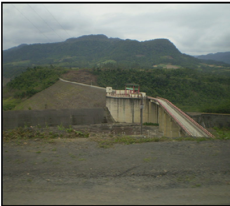
Foto 4. Barragem Norte – fotografia do autor no dia 22/10/2010.
