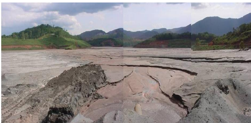
Figura 6 - Vista geral a partir do ponto de lançamento da praia de rejeitos da barragem de Campo Grande, CVRD S/A, Mariana. (Fonte: D'Agostino, 2008).
