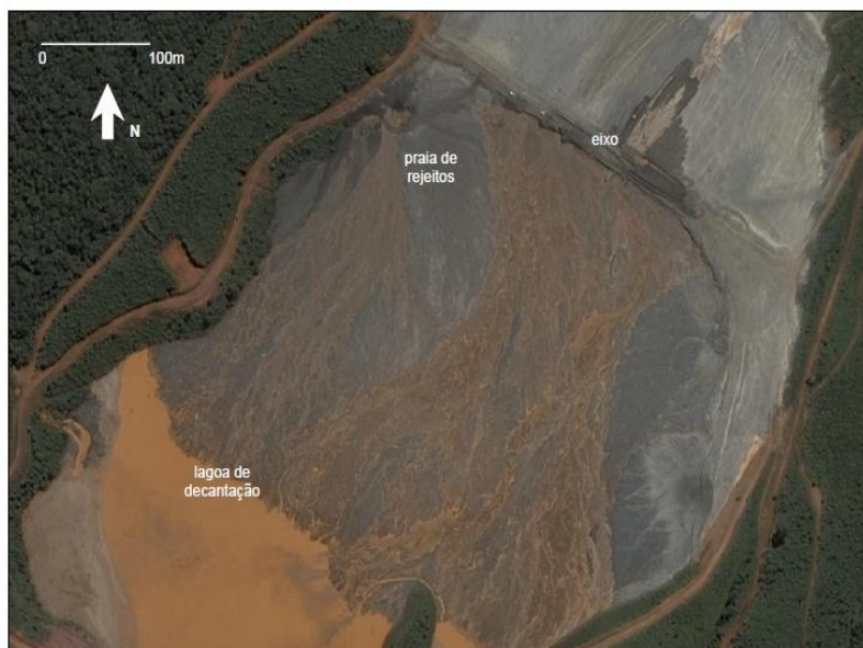
Figura 5 - Foto aérea da barragem de rejeitos de Campo Grande, CVRD S/A, Mariana. (Fonte: D'Agostino, 2008).
