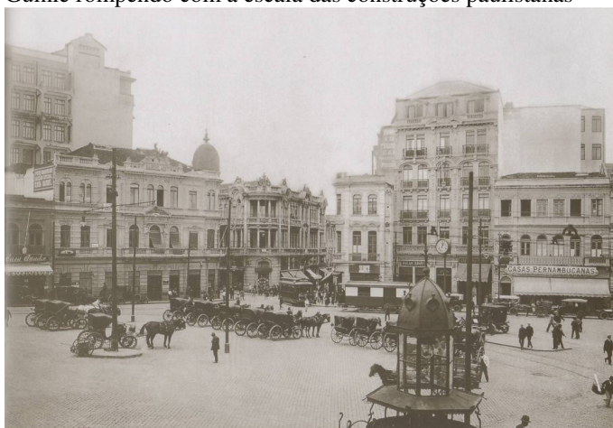
1916 - Vista da Praça da Sé, pormenor. Novamente, no canto esquerdo da foto, vemos a silhueta do Edifício Guinle rompendo com a escala das construções paulistanas
