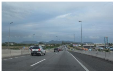
Figura 142: Viaduto sobre BR-486 – Itajaí (S-N).
