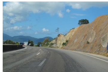
Figura 13: BR-101. Contenção de talude.
