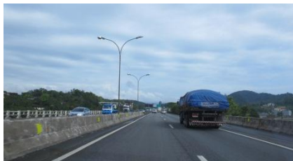
Figura 141: Viaduto sobre ferrovia ALL – Joinville (S-N).
