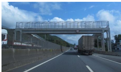
Figura 143: Passarela, única no trecho – Pirabeiraba (S-N).
