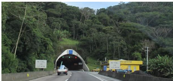
Figura 138: Base de Atendimento ao Usuário - túnel do Morro Do Boi – Balneário Camboriú km 142. Fonte: A autora, 2012.
