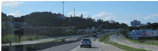
Figura 121: Acesso principal para Biguaçu km 198 (S-N). Fonte: A autora, 2012.
