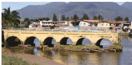
Figura 86: Antiga ponte do rio Mauim e atual Pier.
