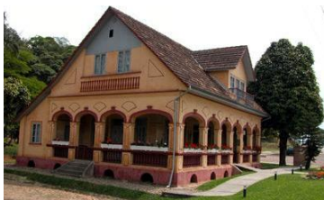
Figura 66: Casa Krüger, Joinville vista BR-280.
