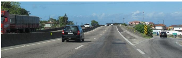
Figura 120: Acesso SC-408 para Antônio Carlos km 192 (S-N). Fonte: A autora, 2012.
