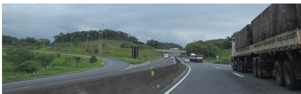
Figura 94: Acesso Sul para Joinville km 50 (S-N) Fonte: A autora, 2012
