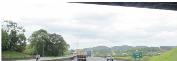
Figura 95: Interseção acesso Sul Joinville km 50 (N-S). Fonte: A autora, 2012.
