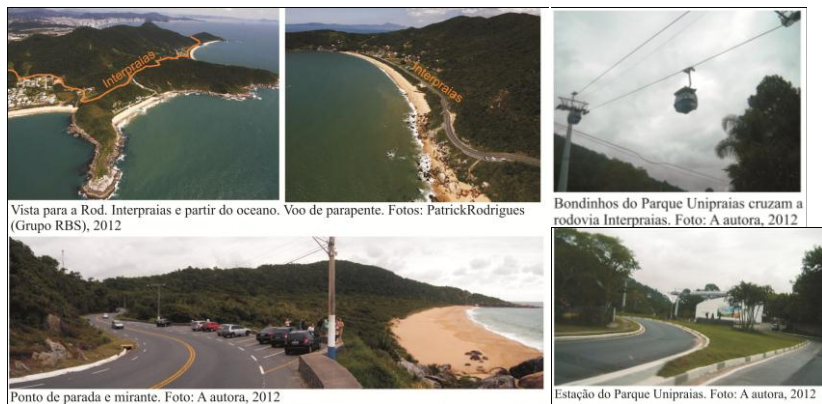
Figura 84: Rodovia Interpraia Balneário Camboriú-Itapema.
