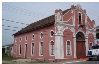
Figura 71: Antigo Cine Theatro, à direita Ponte do Rio Tijucas. Fonte: Alquimia, 2012.
