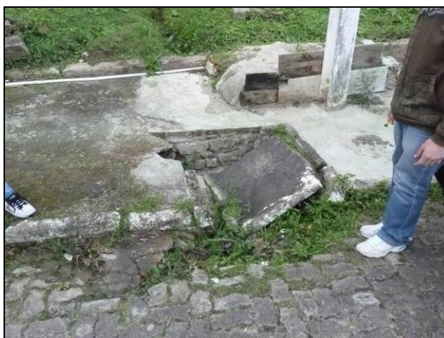
Figura 3: degradação dos dispositivos de drenagem
