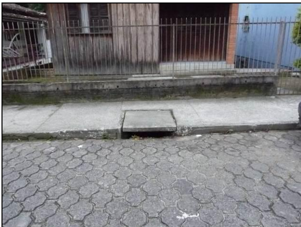
Figura 82: caixa coletora em boas condições.
