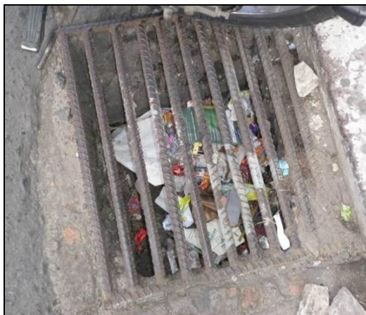
Figura 90: caixa coletora com grelha com sua capacidade reduzida pela presença de resíduos sólidos.
