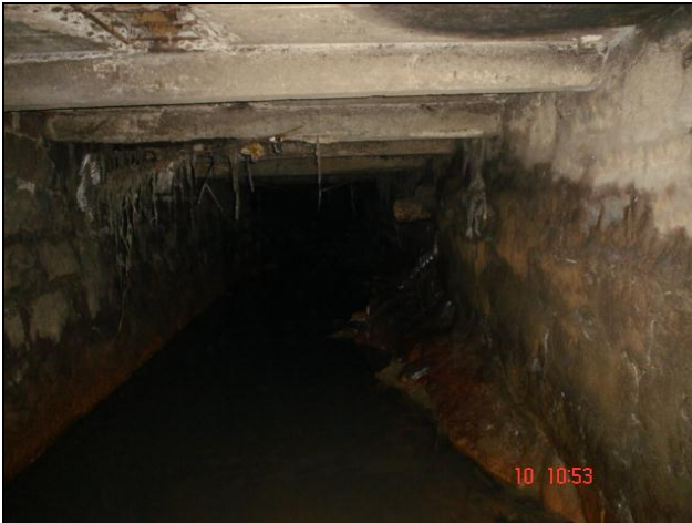
Figura 71: passagem sobre edificações
