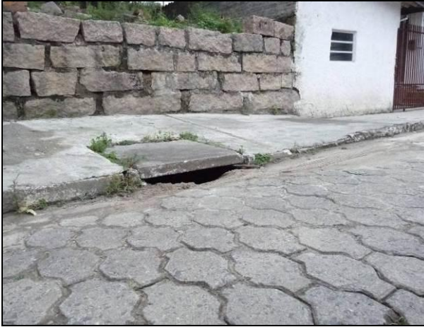
Figura 83: caixa coletora com presença de sedimentos.
