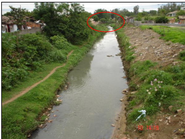
Figura 75: ponte sobre o Rio não canalizado.
