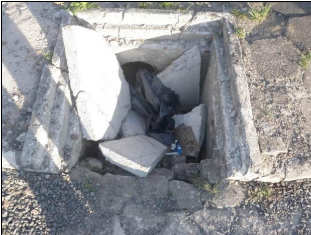
Figura 84: caixa coletora inutilizada por vandalismo.
