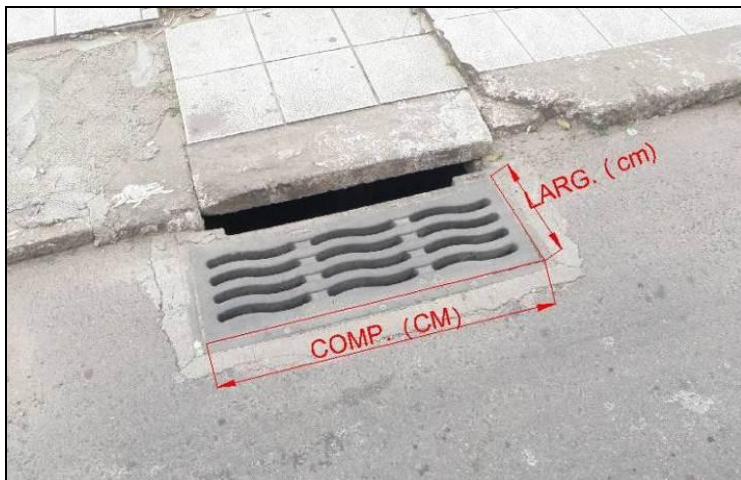
Figura 79: método de coleta de dados das caixas coletoras de sarjeta com grelha. (N=6.826.847m; E=658.844m)
