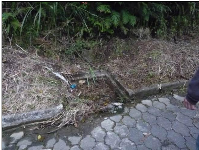
Figura 85: caixa coletora inutilizada por falta de limpeza.
