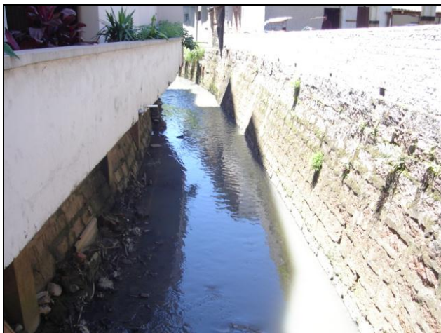
Figura 72: trecho em transição com escoamento aberto Fonte Protol Consultoria e Engenharia
