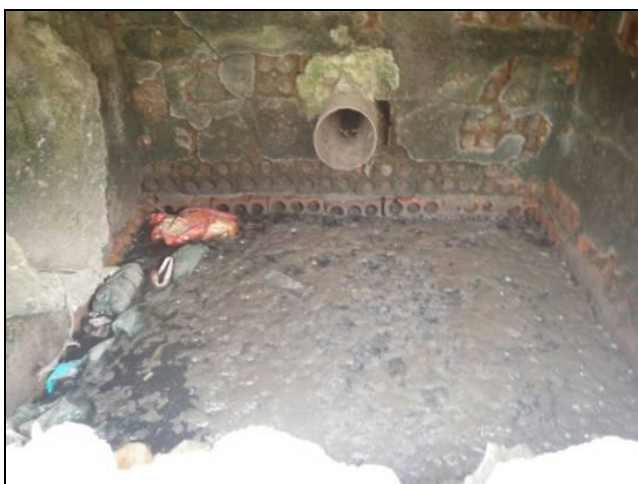
Figura 96: caixa coletora de água pluvial com ligações de esgoto sanitário - B
