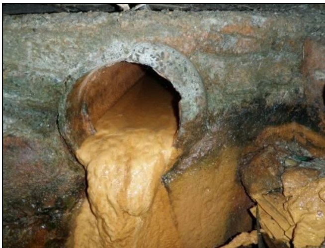
Figura 93: despejo de esgoto industrial em caixa coletora de água pluvial
