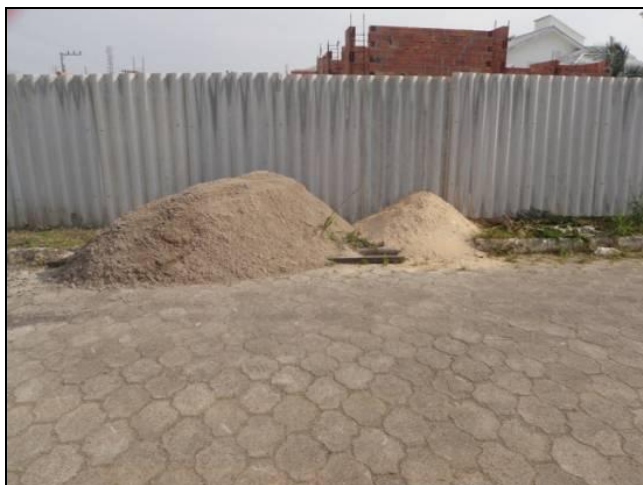
Figura 87: depósito de areia e argamassa pronta sobre a calçada.
