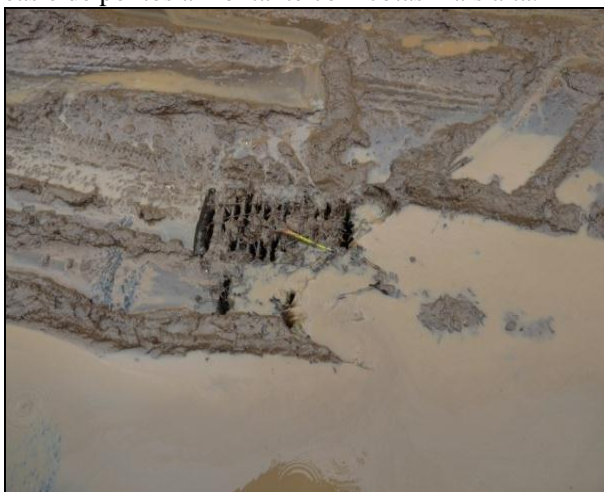
Figura 91: caixa coletora com grelha grande quantidade de sedimentos.
