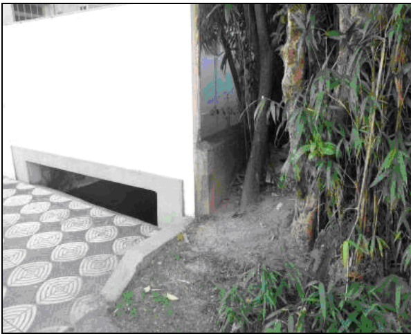
Figura 62: edificação sobre as paredes e laje de cobertura sobre o rio criciúma.(E=658.708m;N=6.826.541m)
