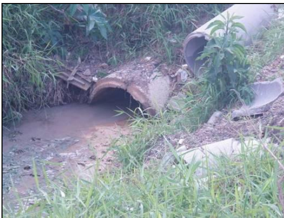
Figura 47: início da canalização do córrego.
