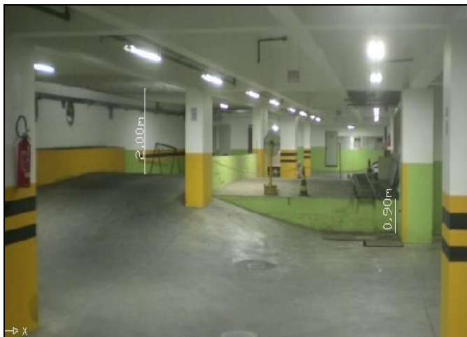
Figura 64: garagem do shopping com a passagem sobre o Rio Criciúma. (P: N=6.826.572m; E=659.309m)
