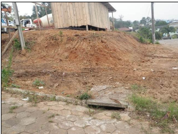
Figura 2: exposição de solo com lançamento de sedimentos no sistema de drenagem
