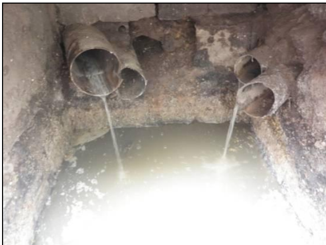
Figura 95: caixa coletora de água pluvial com ligações de esgoto sanitário - A
