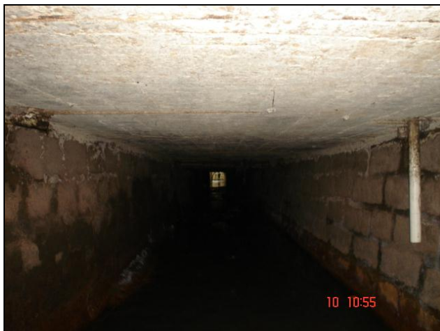
Figura 69: canalização do Rio Criciúma próximo a rua Felipe Schmidt
