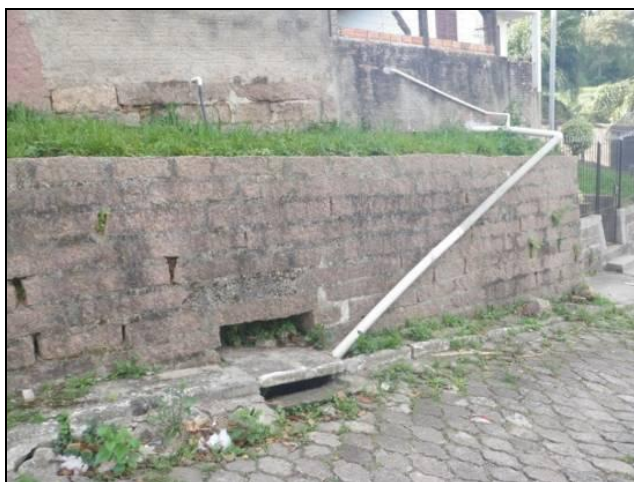
Figura 94: ligação de esgoto residencial em caixa coletora de água pluvial
