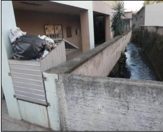
Figura 61: edificação sobre as paredes e sacada sobre o rio criciúma. (E=658.718m;N=6.826.524m)
