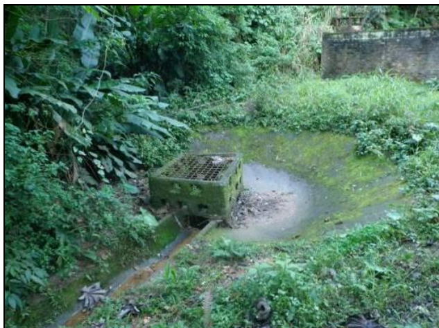
Figura 50: transição de um rio perene com escoamento a céu aberto para escoamento canalizado subterrâneo.
