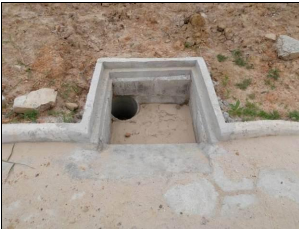
Figura 89: depósito de material granular em caixa coletora originário da pavimentação de ruas.
