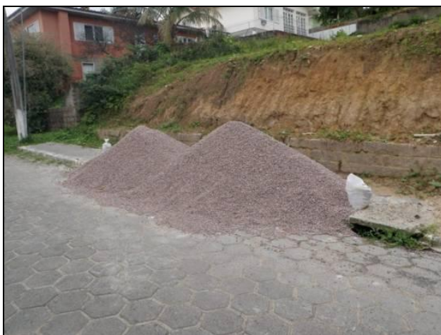
Figura 88: depósito de brita sobre a calçada e caixa coletora de águas pluviais.
