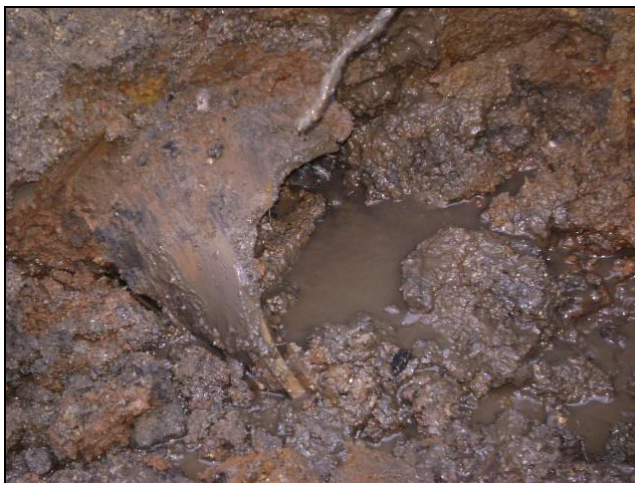
Figura 141: tubulação com seção entupida por sedimentos. Fonte ITAJUÍ, 2011.
