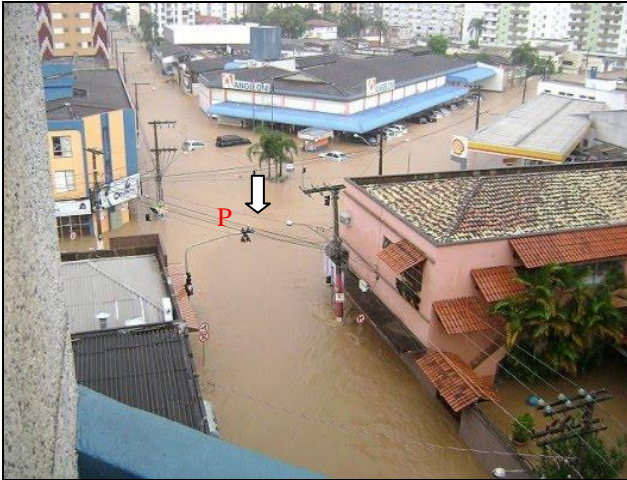
Figura 10: inundação em área onde o rio Criciúma encontra-se sob as edificações. (P: N=6.826.924m; E=659.734m)
