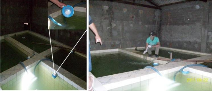
**Figura 8:** Sítio 3 de coleta, na SAC, sendo as coletas realizadas nestes tanques reservatórios, mostrando as pastilhas de cloro utilizadas para tratamento da água.
