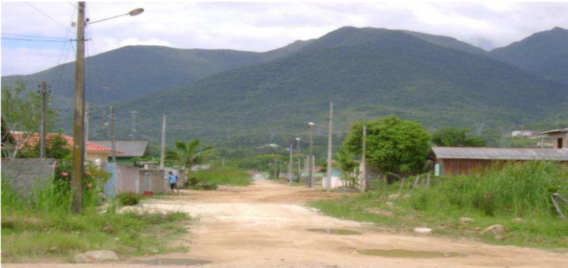
Foto 9 - Precariedade da Rua 15. Foto de Andréa C. 2009.
