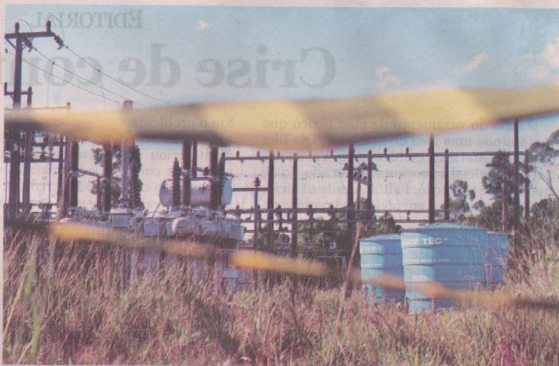
Setenta mil litros. Água contaminada com óleo dos transformadores está armazenada em sete caixas de fibra
