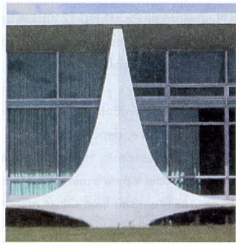
Uma coluna da fachada do Palácio da Alvorada, em Brasília (DF).
