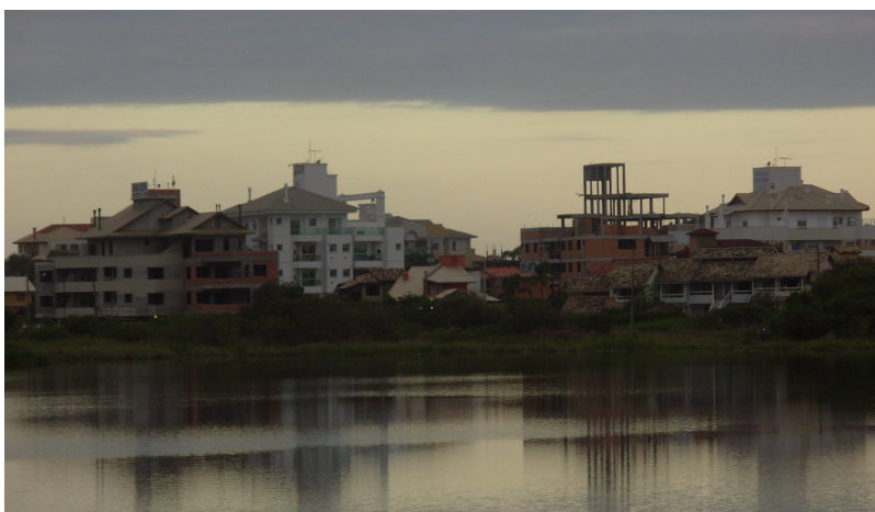
Figura 8: Foto (d) Lagoa Pequena (2011) – detalhe das construções mostradas na Figura 7
