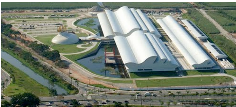
Figura 12: Hospital Rede Sarah, Rio de Janeiro - Brasil - Arquiteto: João Filgueiras Lima.
