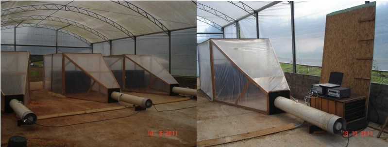
Figura 9 - Visão dos túneis construídos sobre as leiras de compostagem e a direita, monitoramento das emissões pelo analisador de gases INNOVA 1412.
