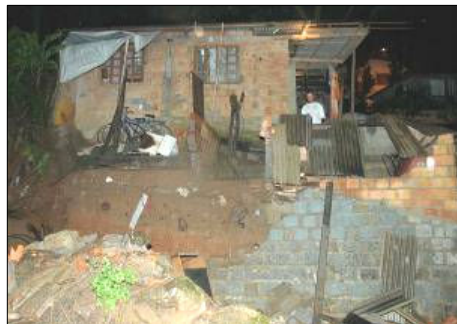
Figura 32: no Morro do Mocotó, muro rompido após chuva intensa no dia 5 de novembro de 2008. Fonte: Diário Catarinense
