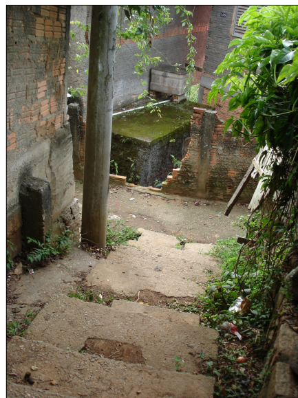
Figura 38: no Morro da Mariquinha, matacão sustentado por uma árvore ameaça a residência. Fonte: Arquivo CEPED (2006) Figura 39: muro rompido pelo escoamento vindo pela escadaria. Fonte: Arquivo CEPED (2006)
