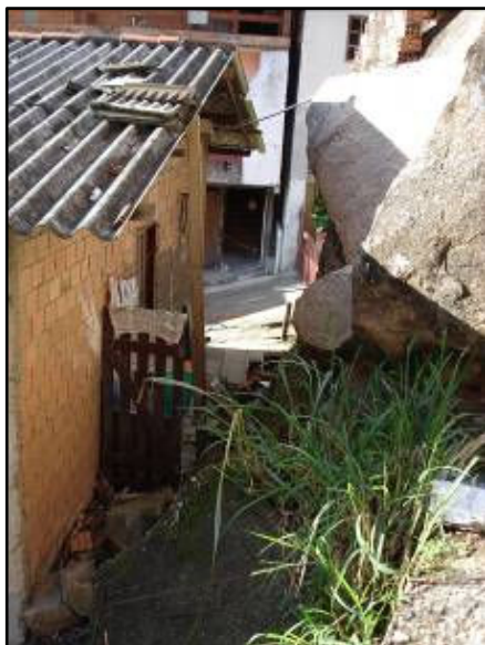
Figura 34: taludes de corte feitos para a construção das casas expõem blocos. Fonte: Arquivo CEPED (2006)
