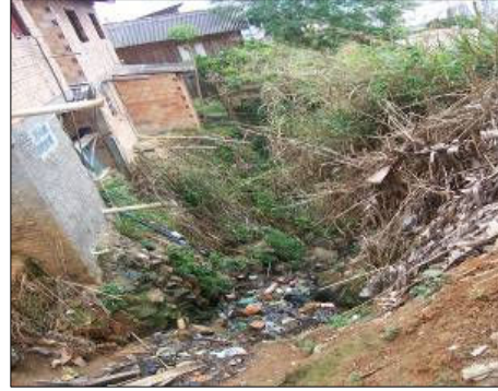
Figura 18: no Morro do Céu, descarte de lixo e o lançamento de efluentes domésticos no canal de drenagem. Fonte: Arquivo CEPED (2006)
