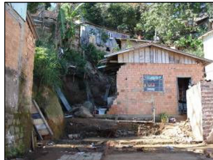
Figura 33: parte da casa destruída devido a queda de uma árvore. Fonte: Arquivo CEPED (2006)
