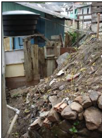
Figura 35: aterro elaborado com restos de lixo e entulho. Fonte: Arquivo CEPED (2006)
