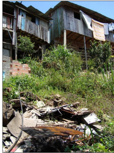
Figura 85: baixo padrão construtivo das moradias e acúmulo de entulho, no Morro da Penitenciária. Fonte: Saito (2010).
