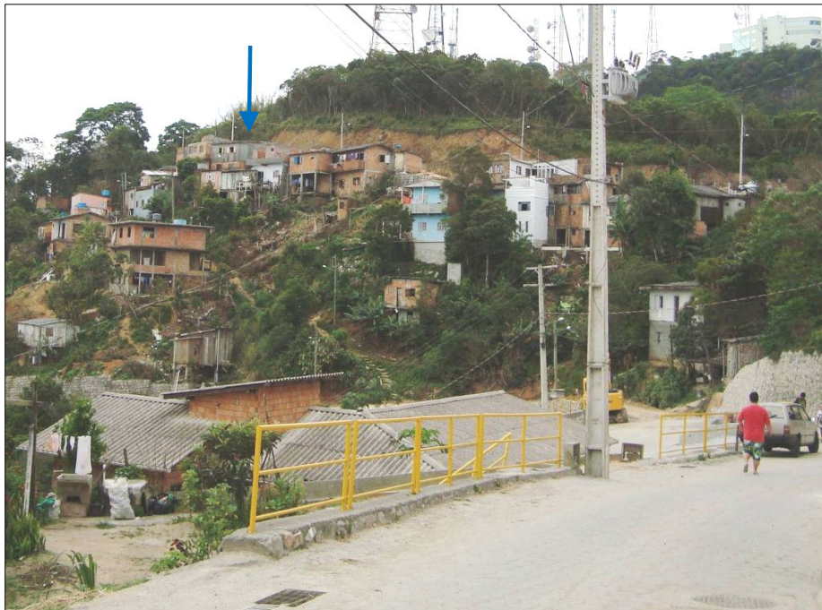
Figura 76: em 2010, a servidão Ayrton Senna recebeu pavimentação, barras de proteção e diversos muros de contenção foram construídos. Observar, ao fundo, a abertura da rua General Vieira da Rosa, que dá acesso ao Mont Serrat. Fonte: Saito (2010)
