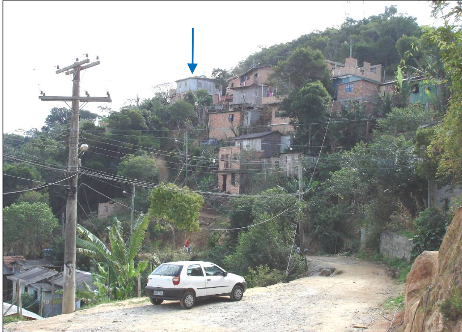
Figura 75: em 2006, no Alto da Caieira não havia pavimentação da via tampouco muros de contenção. Fonte: Arquivo CEPED (2006)
