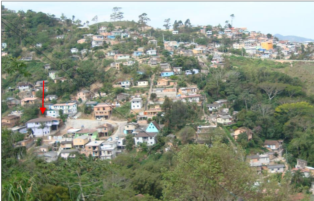
Figura 74: visão de parte do assentamento do Alto da Caieira em 2010. Fonte: Saito (2010)
