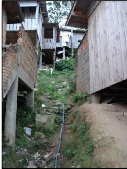
Figura 36: observar o escoamento concentrado da água presente no setor.
