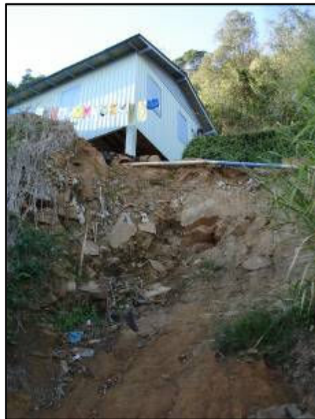
Figura 44: talude de corte expõe saprolito pouco alterado. Fonte: Arquivo CEPED (2006)
