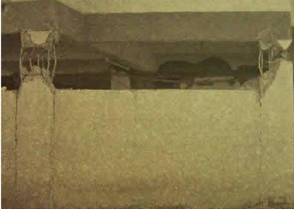
Figura 50 - Exemplo de ruptura de pilar curto
