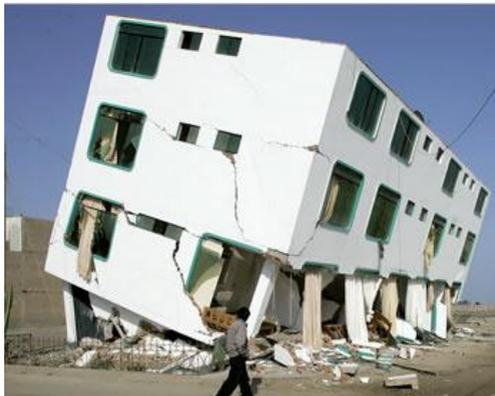
Figura 48 - Exemplo do dano da edificação com andar térreo flexível (Peru, 2007)
