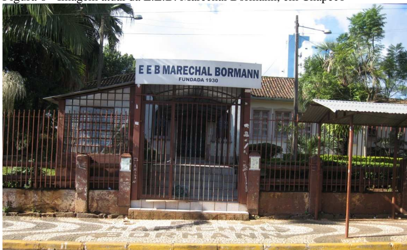
Figura 6 - Imagem atual da E.E.B. Marechal Bormann, em Chapecó
