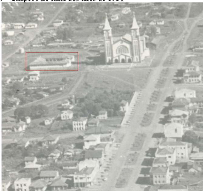
Figura 7 - Chapecó no final dos anos de 1950
