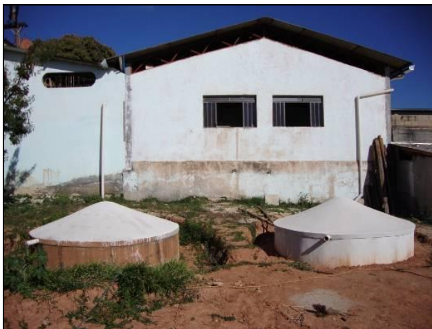
Figura 22 - Jardim Produtivo – sistema de captação de água de chuva. Fotografia: Ivana Cristina Lovo. Outubro/2010.
