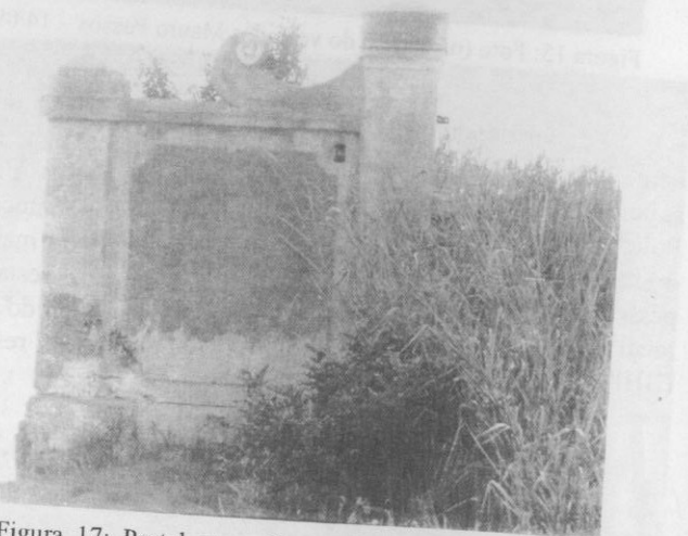
Figura 17: Portal que sobrou após o início da demolição – 1998. Acervo Mauro Passos
