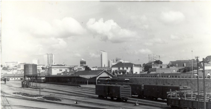
Figura 3: Vista do Pátio Central da RVPSC/RRFSA em Ponta Grossa na década de 1980. Fonte: Acervo Museu dos Campos Gerais/UEPG.
