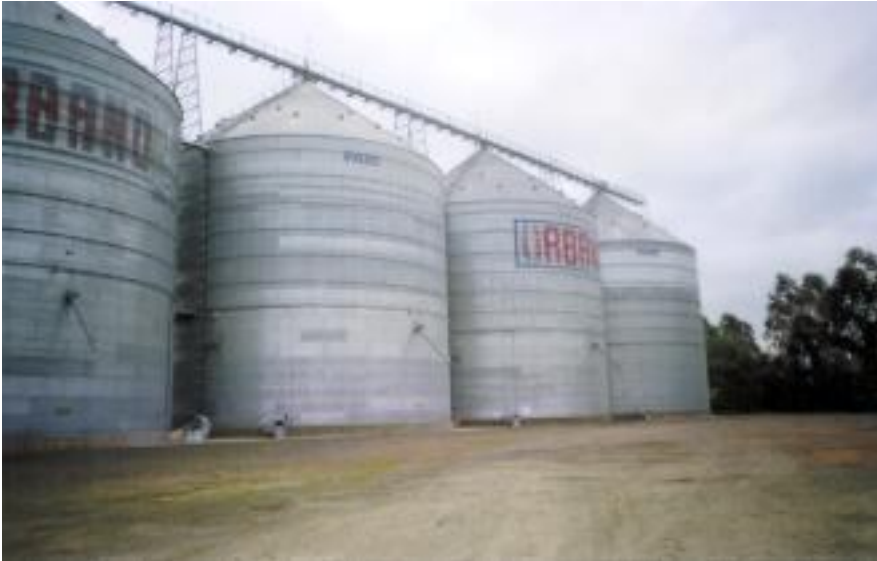
Figura 18: Conjunto de Silos – Empresa Urbano Agroindustrial.
