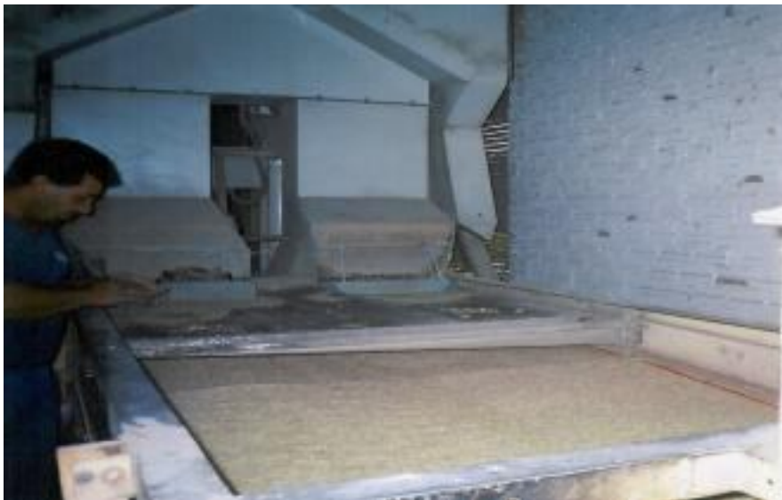
Figura 15: Máquina utilizada no processo de pré-limpeza na Empresa Comércio de Cereais Della.
