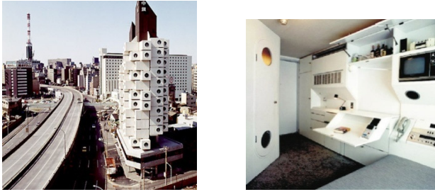
Figura 2 – a) Nakagin Capsule Tower do arquiteto Kisho Kurokawa, Japão (1970) e b) Vista interna de uma das unidades.
