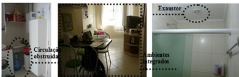
Figura 17 – a) Vista da área de serviço, b) Perspectiva da sala de jantar e estar e c) Banheiro sem abertura para o exterior da habitação.
