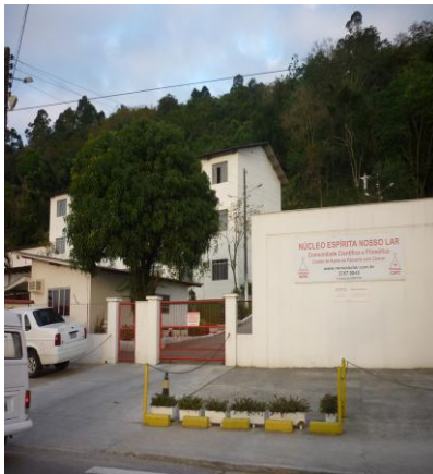
Fachada do NENL
