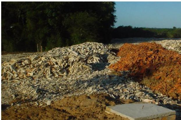
Figura 2.4 – Aterro construído com resíduos de telhas cerâmicas
