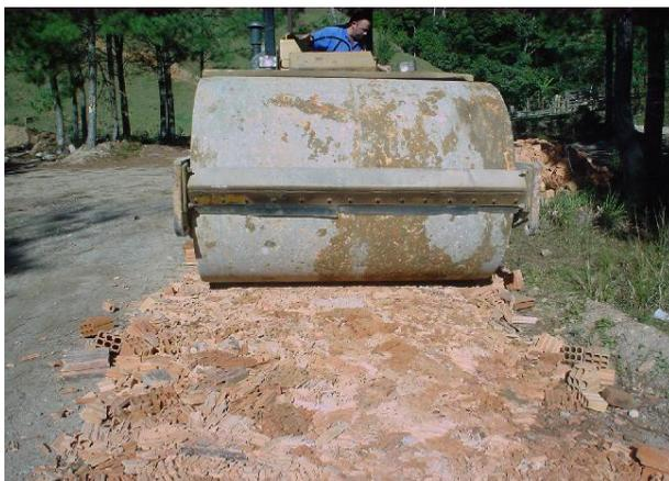
Figura 3.5 – Fragmentação do material cerâmico com rolo liso
