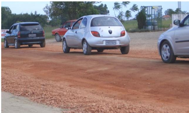
Figura 2.5 – Utilização de resíduo cerâmico como revestimento primário em estradas
