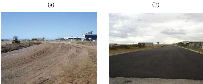
Figura 2.3 – Pavimentação utilizando material reciclado (INSTITUTE PUBLIC WORKS ENGINEERING AUSTRALIA – NSW DIVISION, 2010)
